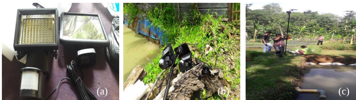
Gambar 5. a) Lampu tenaga solar cell, b) pemasangan pada tiang, c) pemasangan di kolam
