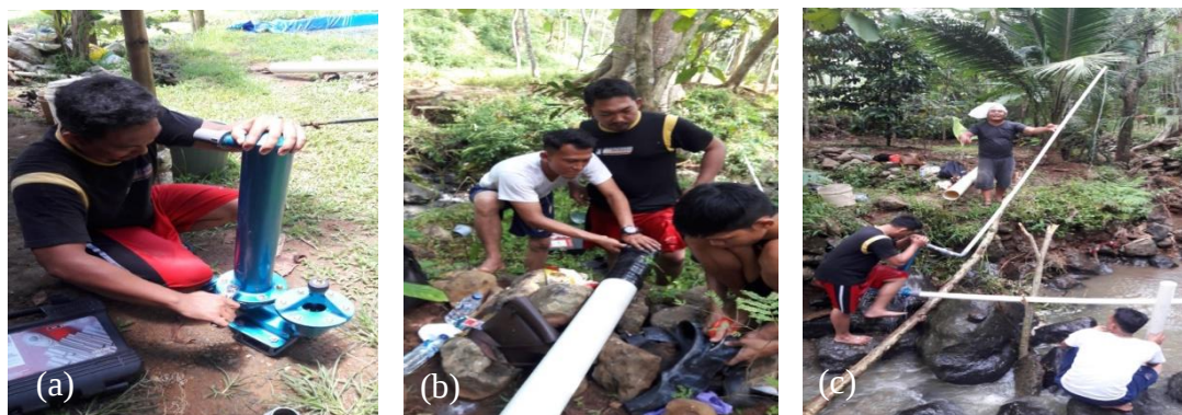
Gambar 3. a) Pengecekan pompa hidram, b) pemasangan isolasi, c) pipa aliran air output
