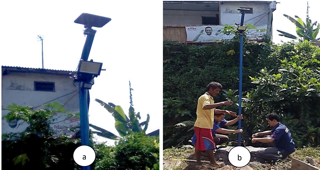
Gambar 6. (a) Pemasangan box lampu , (b) Pemasangan tiang lampu LED
