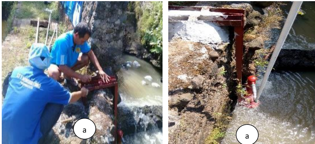
Gambar 4. (a) Pemasangan pompa hidran, (b) Penguatan kontruksi dan pemegang pompa
