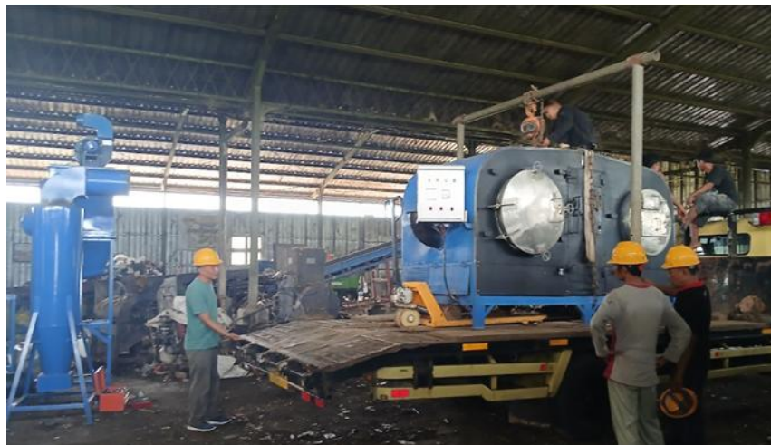
Gambar 2. Pemasangan dan setting mesin pirolisis
